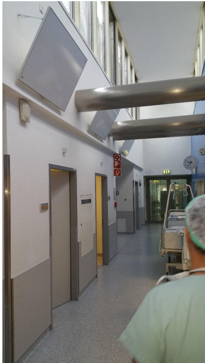
Bild 2: Der Gangbereich in der Entbindungsstation ist nun auch für werdende Mütter und deren Familien behaglich geworden. Schräg angestellte Infrarotpaneele in Wandmontage versorgen den Raum mit optimaler Strahlungswärme.
