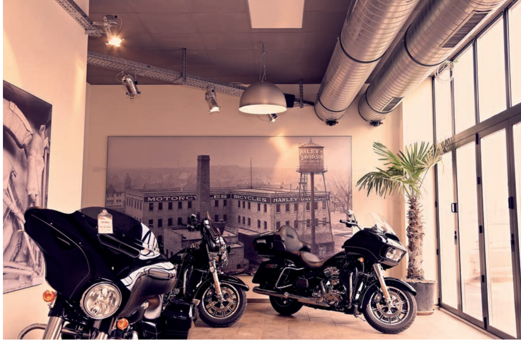
Die Heizpanele von easyTherm sorgen neben dem Restaurant auch in einem kleinen Teil der Ausstellungsfläche von Fischer’s Harley-Davidson für ideale Temperaturschichtung vom Boden bis zur Decke.
